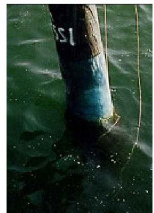
Vista de la zona dañada reparada
