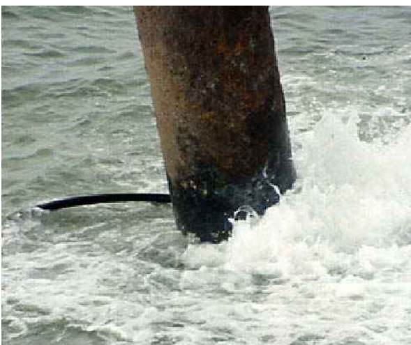
Limpieza con chorro de arena o máquina rotativa neumática
