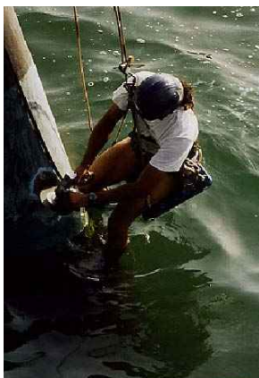
Limpieza del soporte con radial neumática y disco abrasivo
