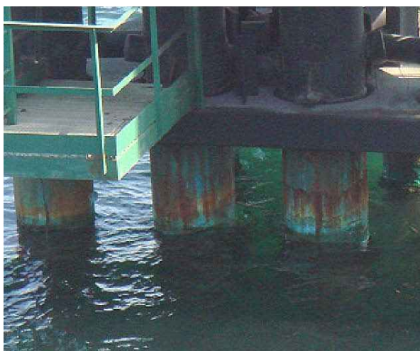
La masilla está bien aunque cubierta por manchas de óxido que provienen de la estructura metálica superior que está oxidada.
