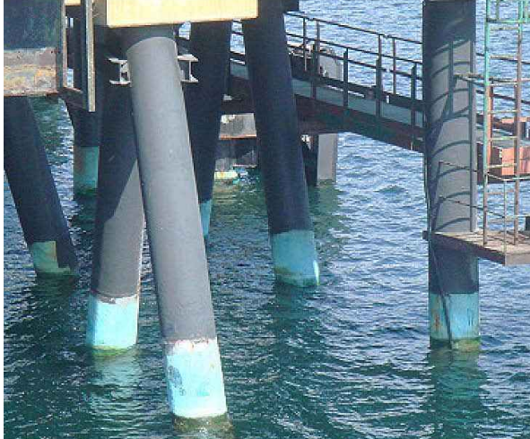
Detalle de pilotes de la Plataforma "6":
