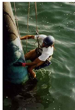
Aplicación de la Techmodur Masilla Polivalente
