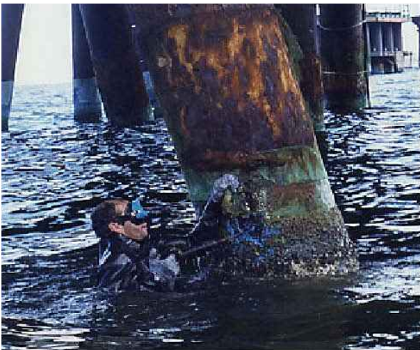
Eliminación de las capas sueltas y costras de óxido por medio de máquina neumática
