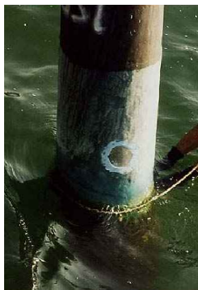
Vista del soporte a grado St3 y la masilla del perímetro lijada,
