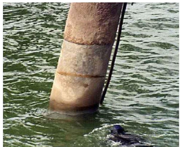
Vista del soporte metálico listo para la aplicación de la Techmodur Masilla Polivalente
