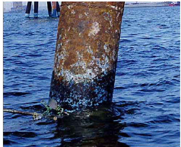
Vista del pilote libre de capas y costras de óxido dejando el hierro visto
