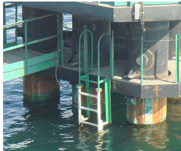
La Techmodur Masilla Polivalente está cubierta de manchas de óxido procedente de la oxidación de la estructura metálica que está por encima.
