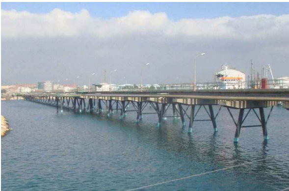
Vista del pantalán de ASES (Tarragona) con los pilotes protegidos en zona de rompiente y marea con la Techmodur Masilla Polivalente
